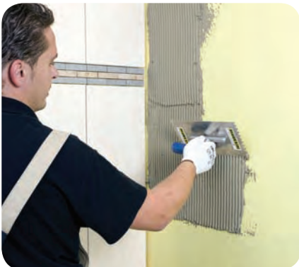
10. Na zaschnutú hydroizoláciu naniesieme zubovým hladidlom Murexin pružnú lepiacu maltu KGF 65.
