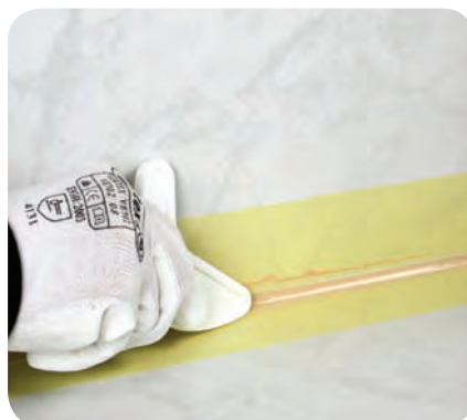
17. Pomocou vhodného nástroja spoj zahladíme a odstránime prebytočný silikón.
