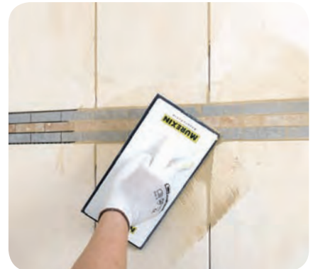
12. Po dostatočnom vytvrdnutí lepiacej malty obklad vyškárujeme. Škárovaciu maltu Murexin FM 60 nanášame vždy pod 45° uhlom na škáry.
