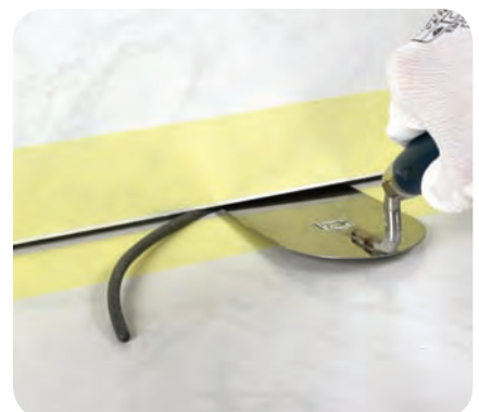
15. Spoje stena-stena a stena-podlaha oblepíme maskovaciu páskou a natlačíme do nich Murexin škárovací povrazec.
