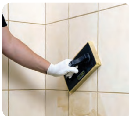
14. Po zaschnutí škárovacej malty obklad dôkladne pomývame čistou vodou a prípadné zbytky škárovacej malty odstránime čističom Murexin Colo SR 30.
