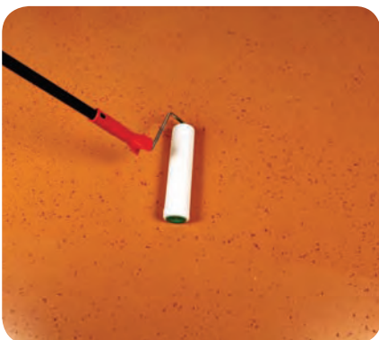
13. Ak sa použili dekoratívne čipsy odporúčame na celý povrch naniesť ochranný uzatvárací náter Epoxy Top Coat EP100 TC.
