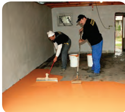
11. Ihneď po roznesení hmoty na podklad ju odvzdušňujeme odvzdušňovacím válcom. Odstránia sa tak vzduchové bubliny, ktoré vznikli pri miešaní živice.
