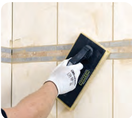
13. Po vyškárovaní a čiastočnom zaschnutí škárovacej malty obklad umyjeme čistou vodou.
